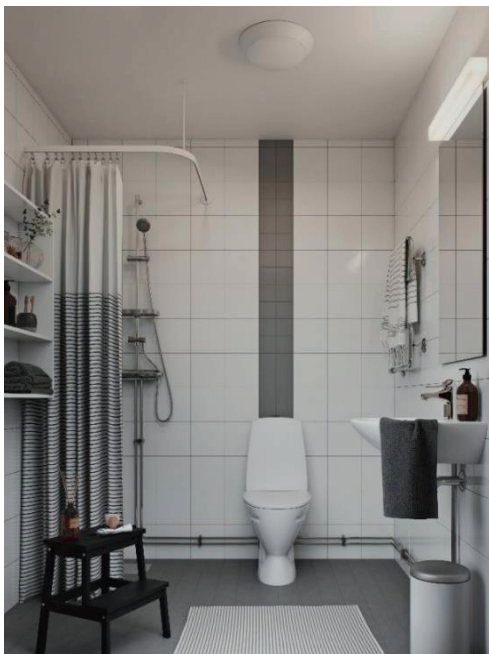
Utanpåliggande förkromade rör i badrum.
